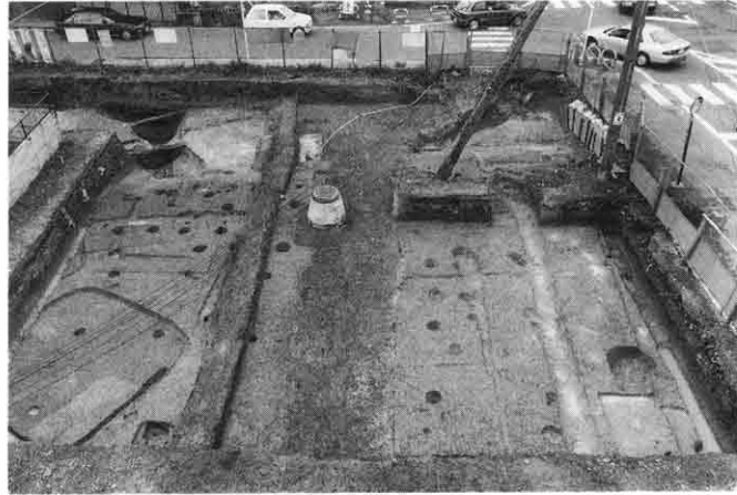
調査地全景(北から)
